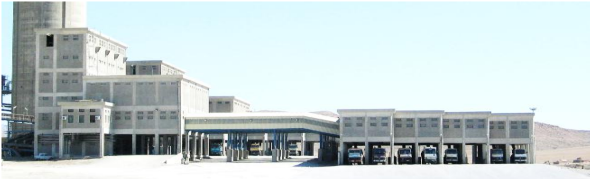
Figure 11 la zone d'expédition du ciment LCM.
