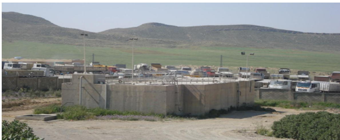
Figure 13 Station de traitement des eaux usées de la cimenterie LCM.
