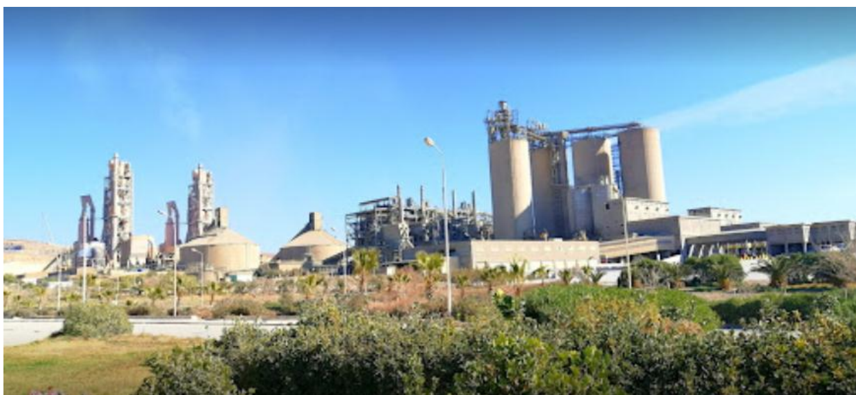
Figure 4 Vu globale de l'usine Lafarge ciment de M'sila LCM.
