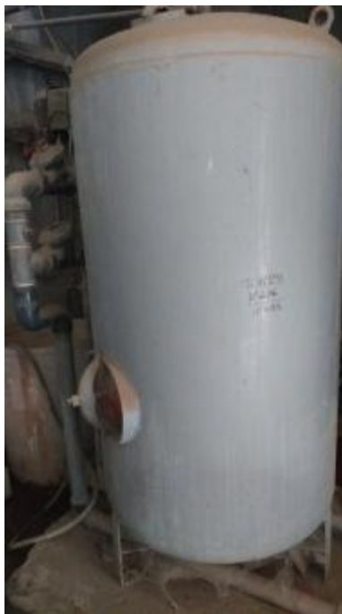
Figure 17 photo du filtre à sable.
