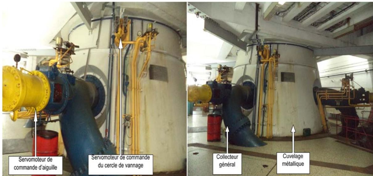
Figure 4.8: étage de turbine [26]
