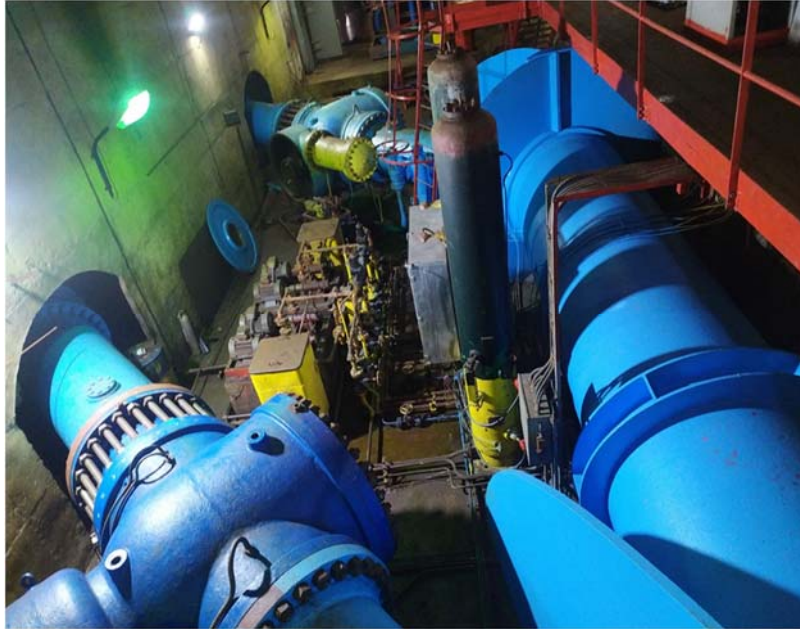
Figure 4.16 : La conduite forcée [27]
