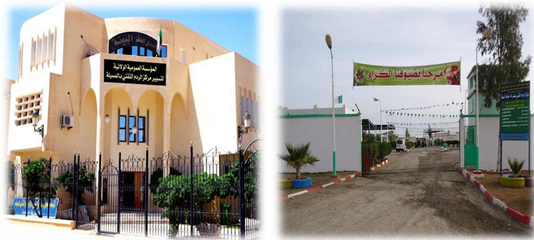
Figure N 24 : L'environnement du lieu de l'implantation du CET de M'sila .
