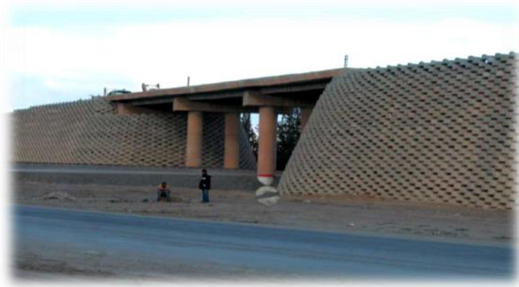
Figure 4.9 : Vue de l'ouvrage en construction
