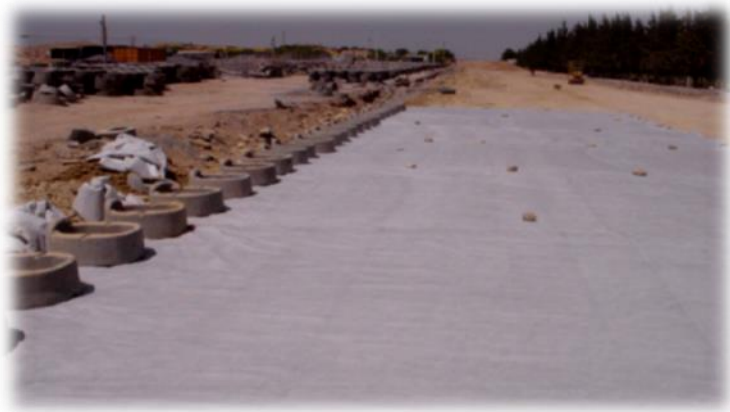
Figure 4.7 : Pose des éléments de parement et des nappes géotextile de renforcement
