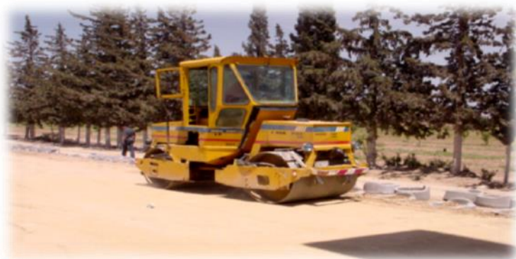
Figure 4.8 : Compactage des couches de remblai
