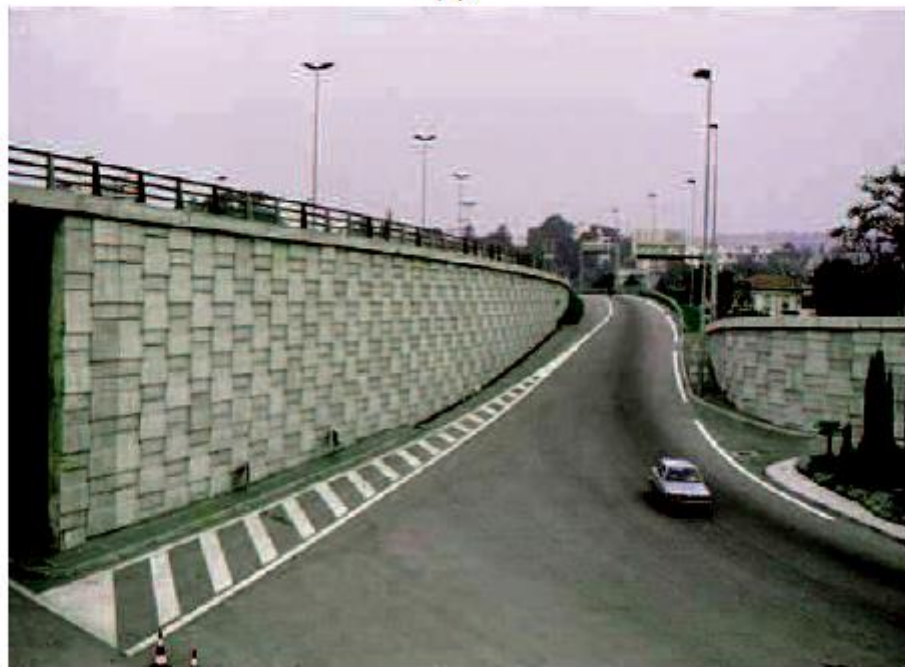
Figure 1.3 : Panneaux de hauteur partielle
