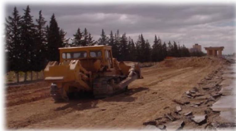
Figure 4.5 : Décapage de 70 cm sur toute la surface du projet
