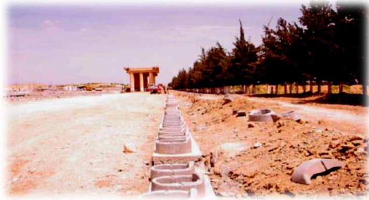
Figure 4.6 : Mise en œuvre du béton de propreté et matérialisation des redans
