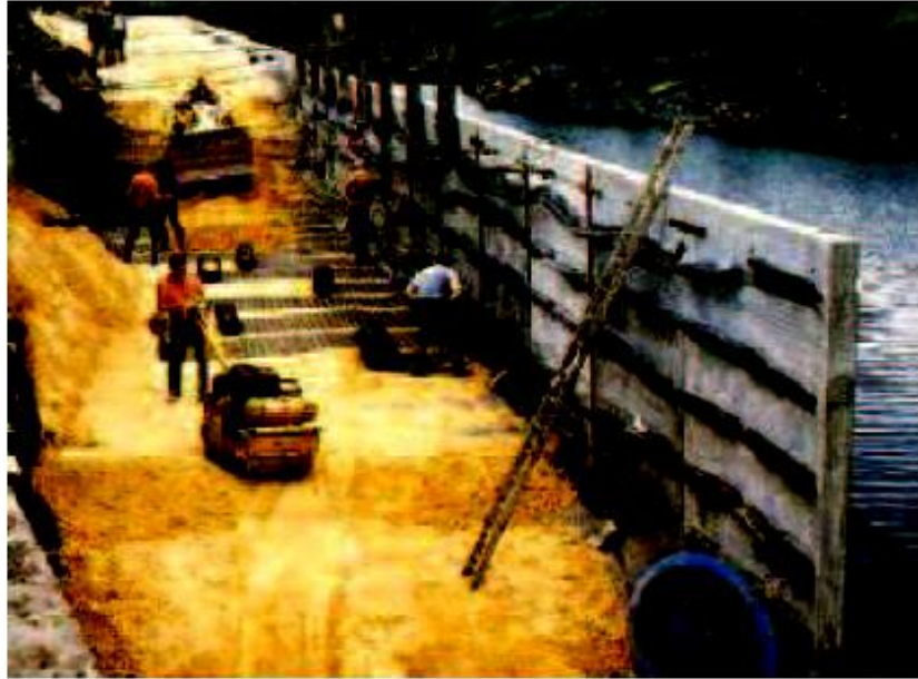
Figure 1.2 : Panneaux de pleine hauteur
