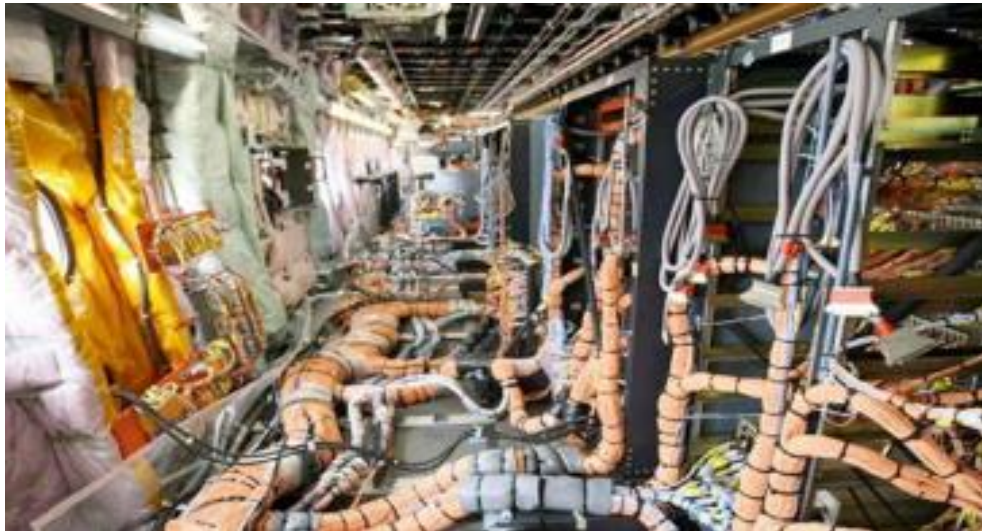
Figure 1.12 : installations de Km de câbles spéciaux à bord d'un airbus.
