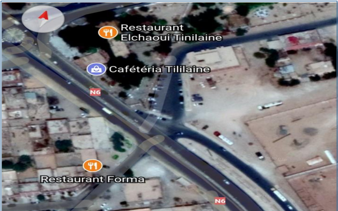
الصورة رقم 53: المفترق قبل التدخل
