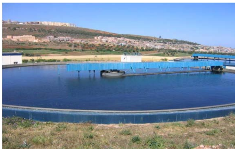
Figure.02: station d'épuration des eaux usées épurées en irrigation (KESSIRA MOHAMED. Algérie 2013)
