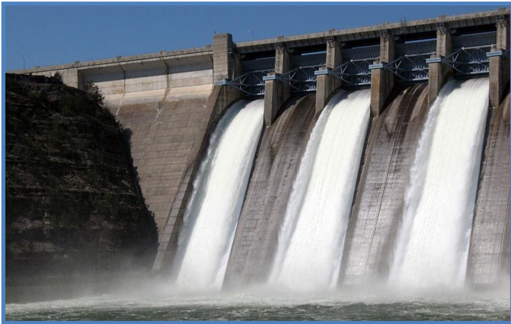
Barrage de Soubella.
