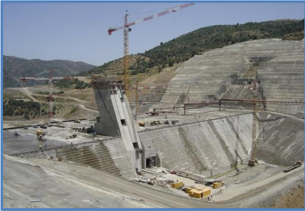
Barrage de Soubella
