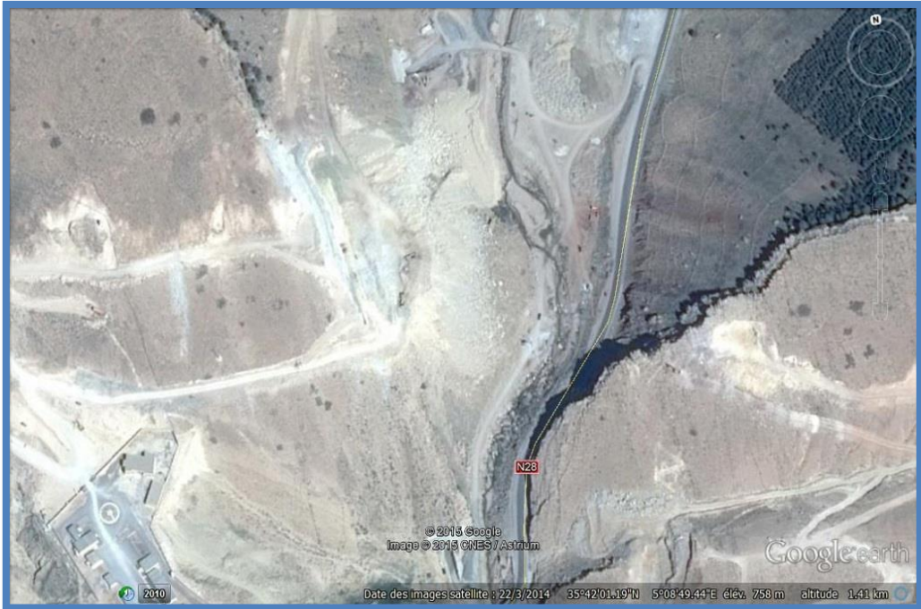
Barrage de Soubella.
