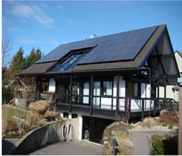
Figure 1.25. sur le toit
