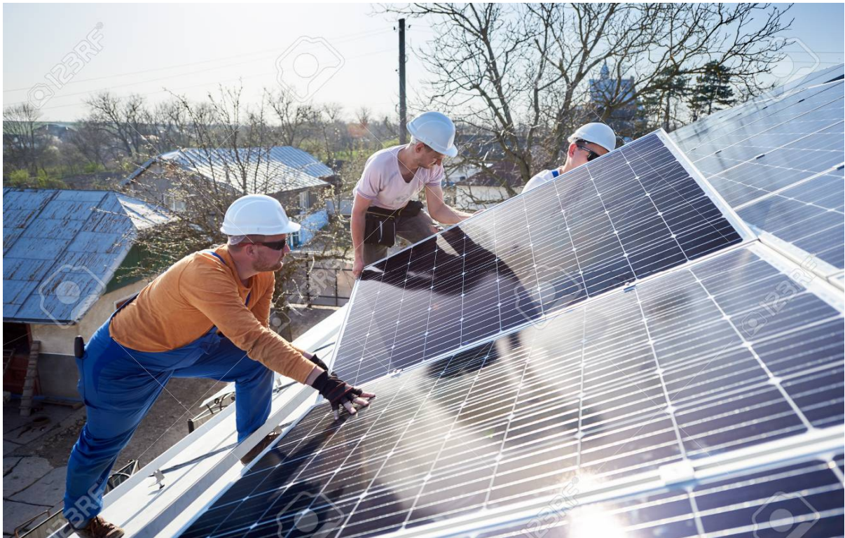
Figure 1.1. Des panneaux photovoltaïques
