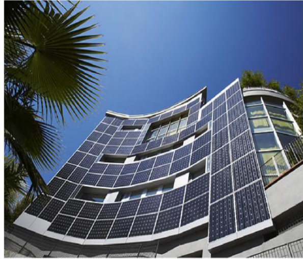
Figure 1.26. sur la façade
