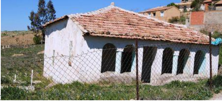
الصورة رقم 10 : البناء باستخدام القرميد في منطقة زواوة
