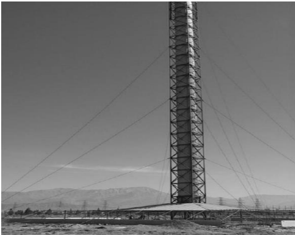
Figure( I . 12 ) :Photo de la centrale à cheminée solaire pilote de Kerman en Iran [21].
