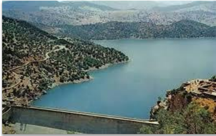
Figure 4. 1: barrage-poids en béton de Oued Fodda
