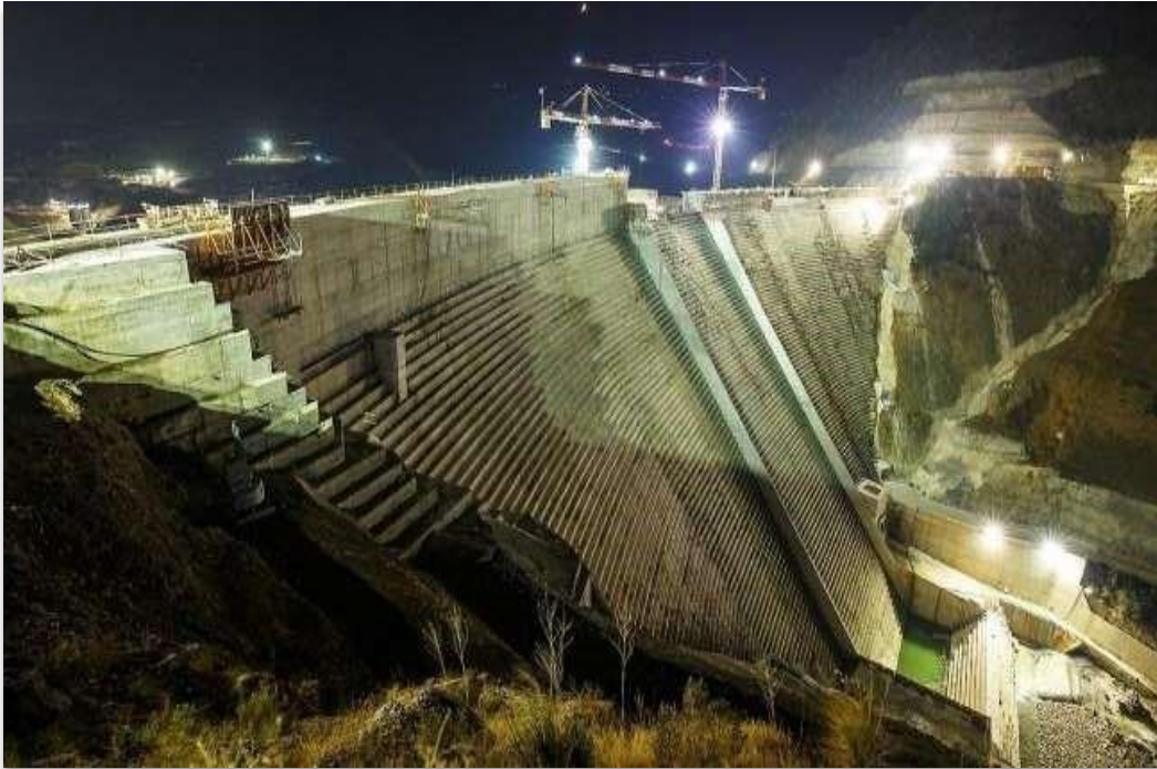
Figure 1.6 : barrage de Tabellout Jijel- Algérie
