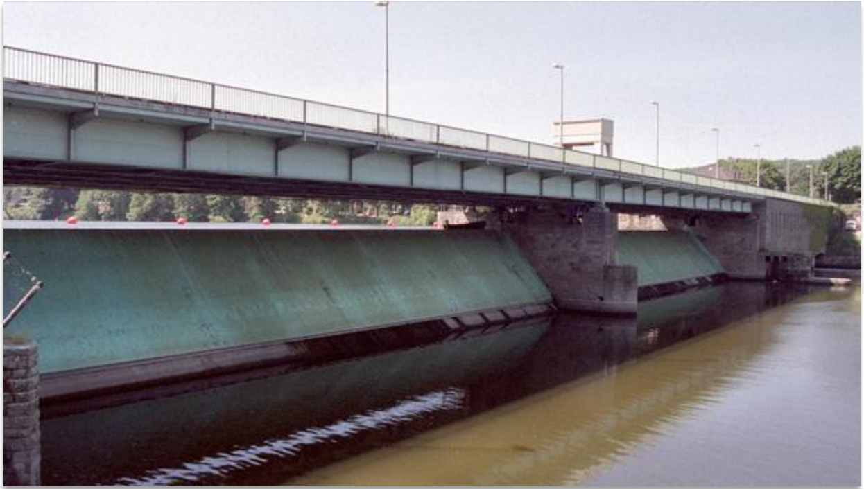
Figure 1.13 : Barrage mobiles à battants à axe horizontal, Kettwig-Allemagne
