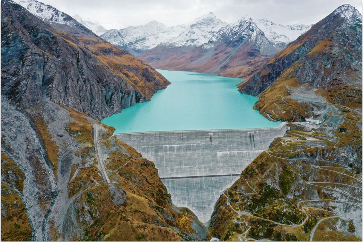
Figure 1.2: Barrage poids de la grande dixence -Suisse
