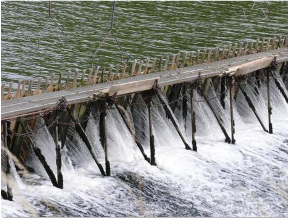
Figure 1.12 : Barrage à aiguille- France
