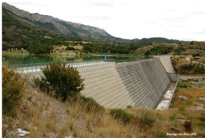
Figure 1.5 : Barrage en BCR du Riou- France
