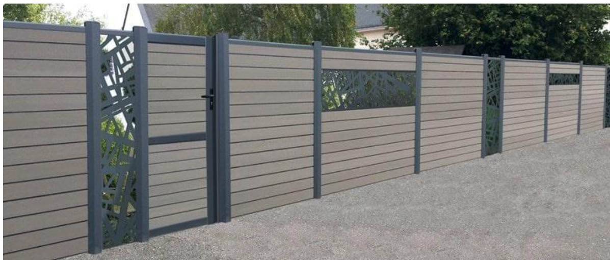
FIG I.18 :Clôture En composite
