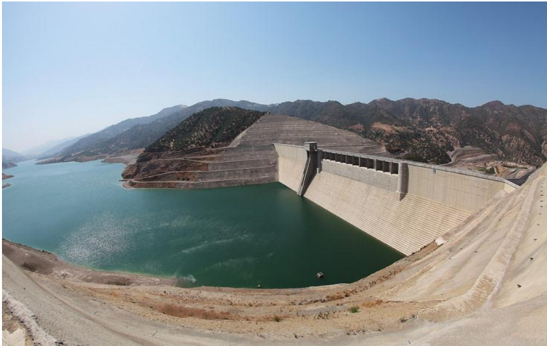
Figure II.11 : barrage de Koudiat Bouira- Algérie
