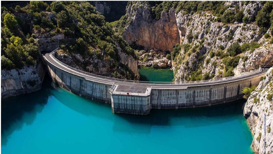
Figure II.7 : Barrage de Sainte Croix
