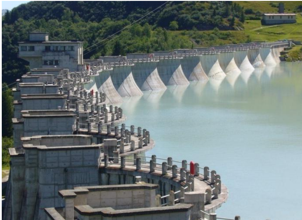
Figure II.10 :barrage de la Girotte- multi-voûtes
