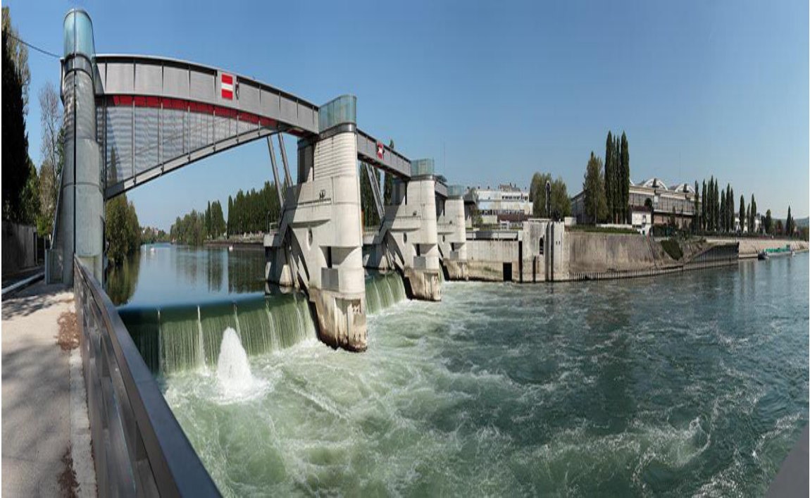
Figure II.5 : Barrage de Chatou-France
