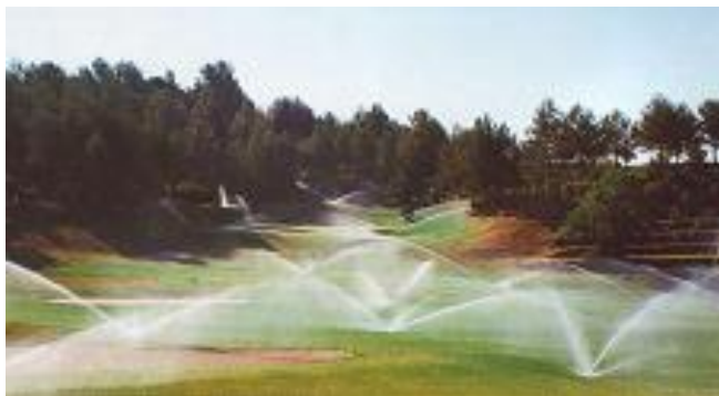
Figure N°3: Irrigation par aspersion (A N S, 1992)
