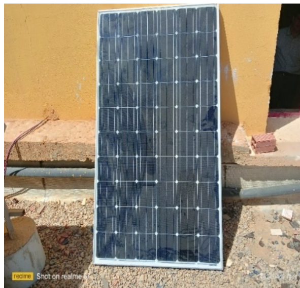
Figure IV-6: Panneaux solaire polycristalline de 250 WC
