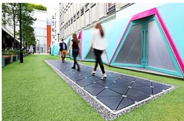
Figure II. 5. Installation de dalles Pavegen sur une allée piétonne.
