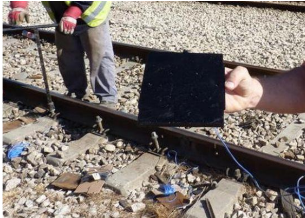
Figure II. 6. Voies ferrées piézoélectriques récupèrent l'énergie produite par le passage des trains.
