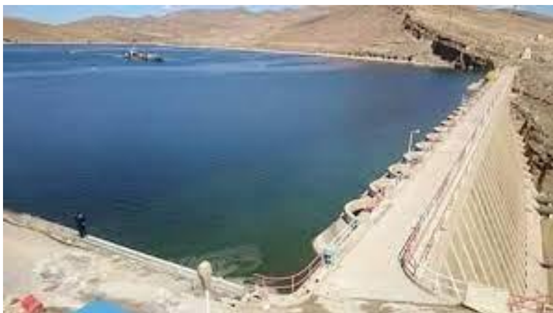
Figure N°06 : barrage du Ksob dans la région de M'sila.
