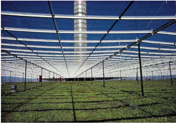
Figure (I.3) : Vue intérieure du collecteur [3].
