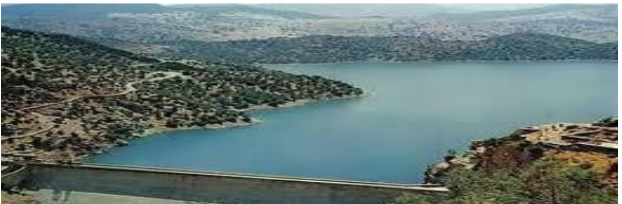
Figure 4.1 :barrage-poids en béton d'Oued Fodda
