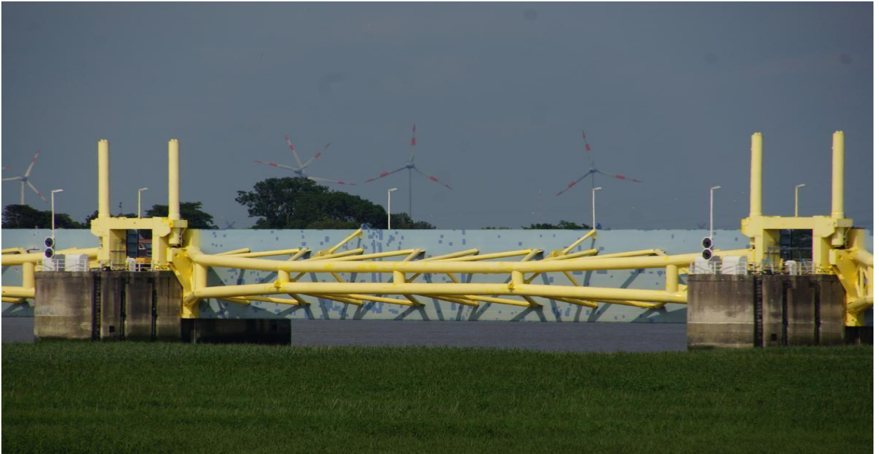
Figure 1.13 : Barrages mobiles à battant {Axe horizontal}
