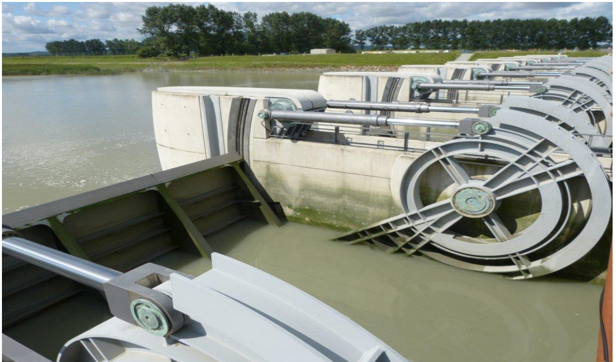
Figure 1.12 : Barrages mobiles à battant {Axe vertical}
