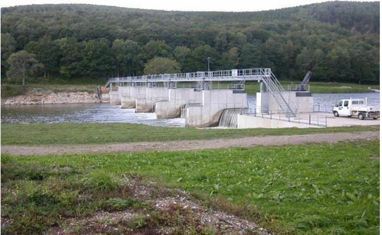
Figure 1.14 : Barrage mobile à clapets
