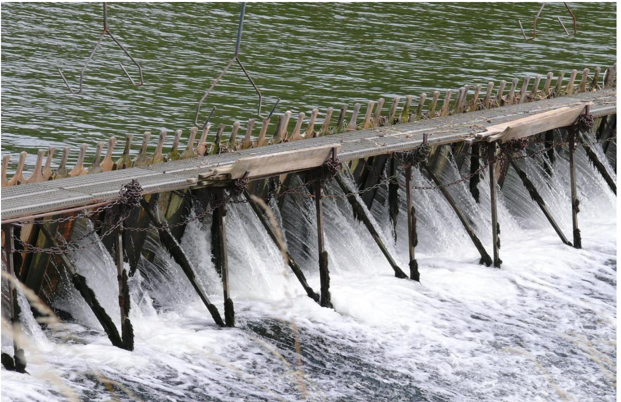
Figure 1.11 : Barrage à aiguilles
