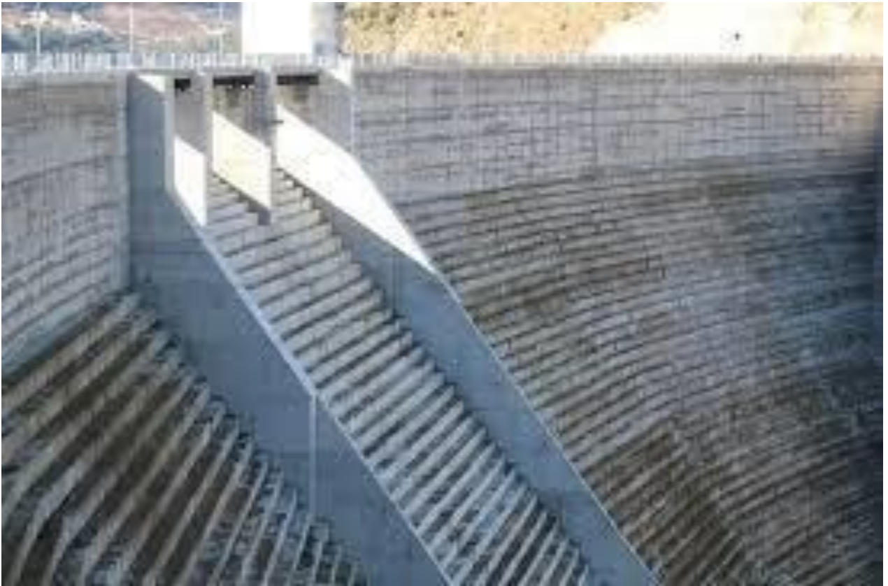
Figure 1.7 : barrage de Tabellout Jijel- Algérie
