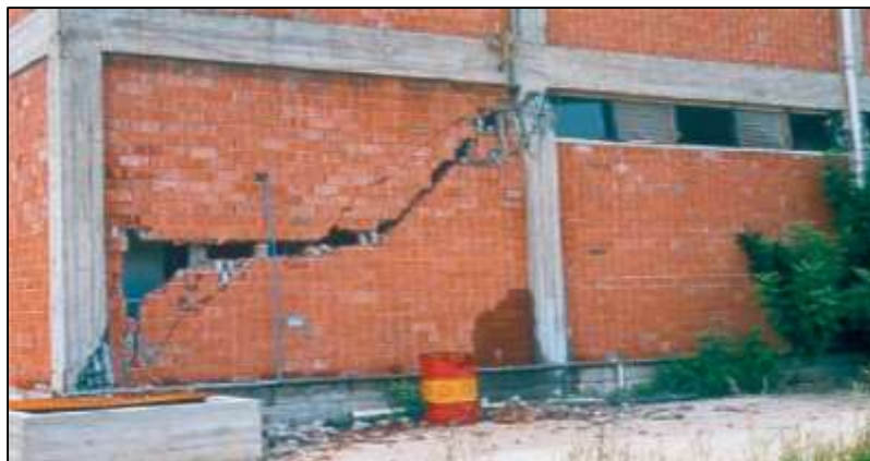
Figure I.10 : Des endommagements à cause de remplissage partiel, (Adana-Ceyhan, Turquie, 1998) [12].
