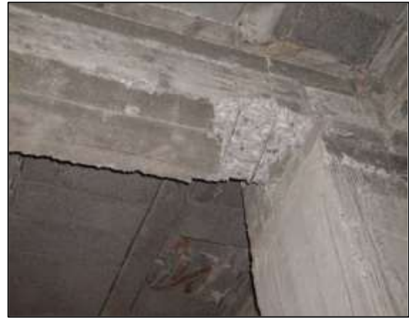
Figure I.20 : Rotule dans la poutre (Comportement recherché) [5].
