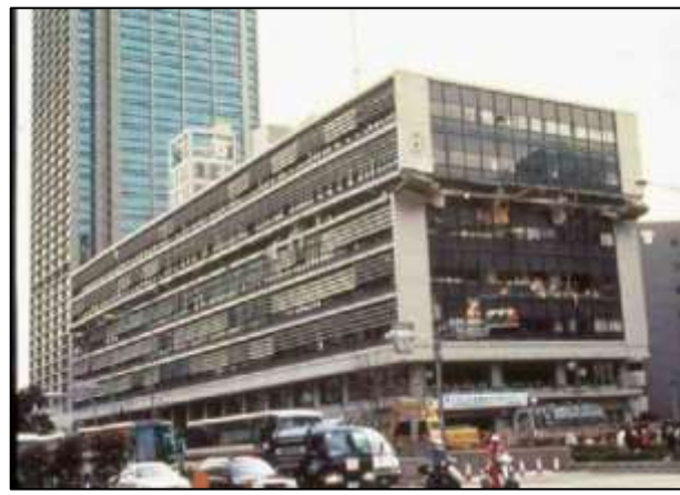
Figure I.8 : Perte d'un étage de la mairie de Kobe (Séisme de Kobe (Japon) en 1995) [8].
