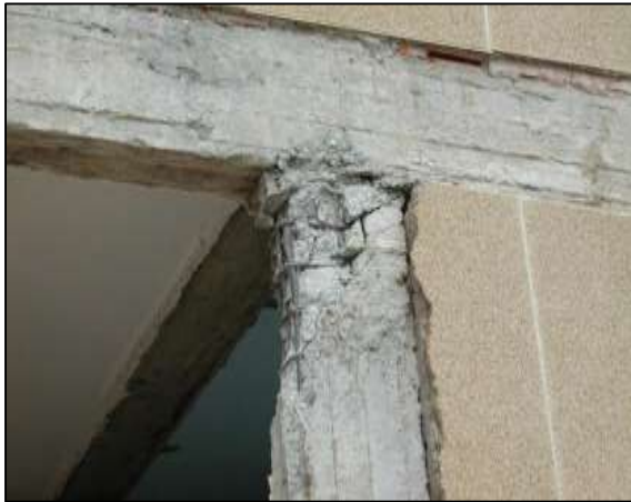
Figure I.19 : Rotule dans le poteau (Comportement à éviter) [5].
