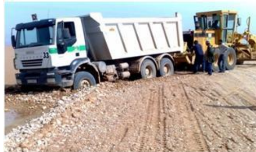
Figure 4.4: Illustration de la faible portance du sol de sebkha saturé sans géotextile
