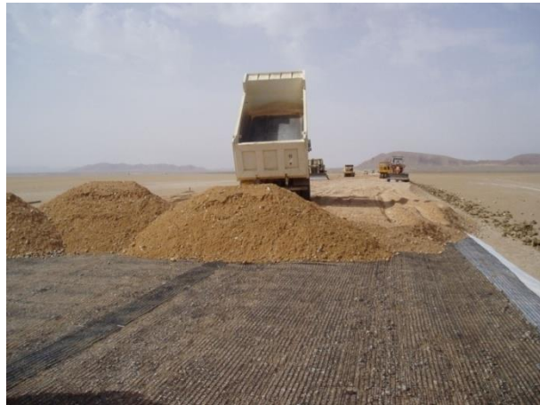
Figure 4.8: Pose de la deuxième couche du remblai
