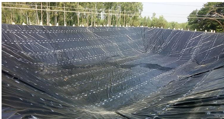
Figure 1.9: Pose de Géomembrane directement sur le sol
