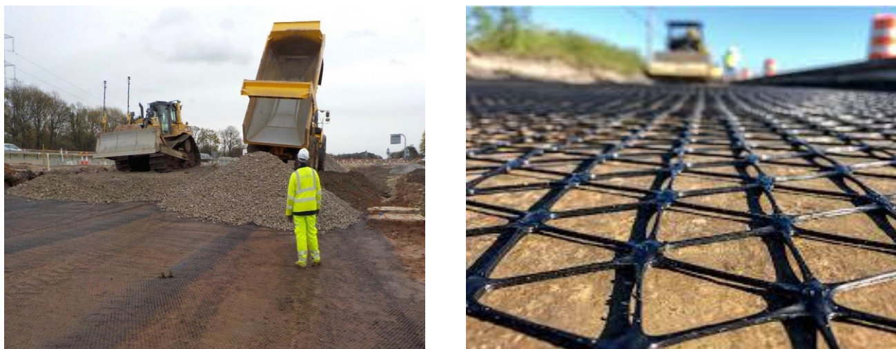
Figure 1.7: Pose de nappe de géogrille directement sur le sol
