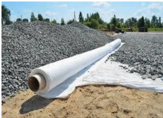
Figure 1.8: Pose de nappe de Géotextil directement sur le sol
