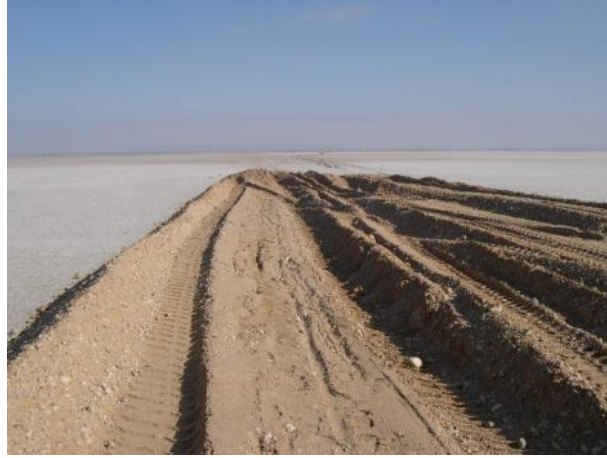
Figure 4.7: Visualisation des difficultés de mise en place de la première couche du remblai sans géotextile
