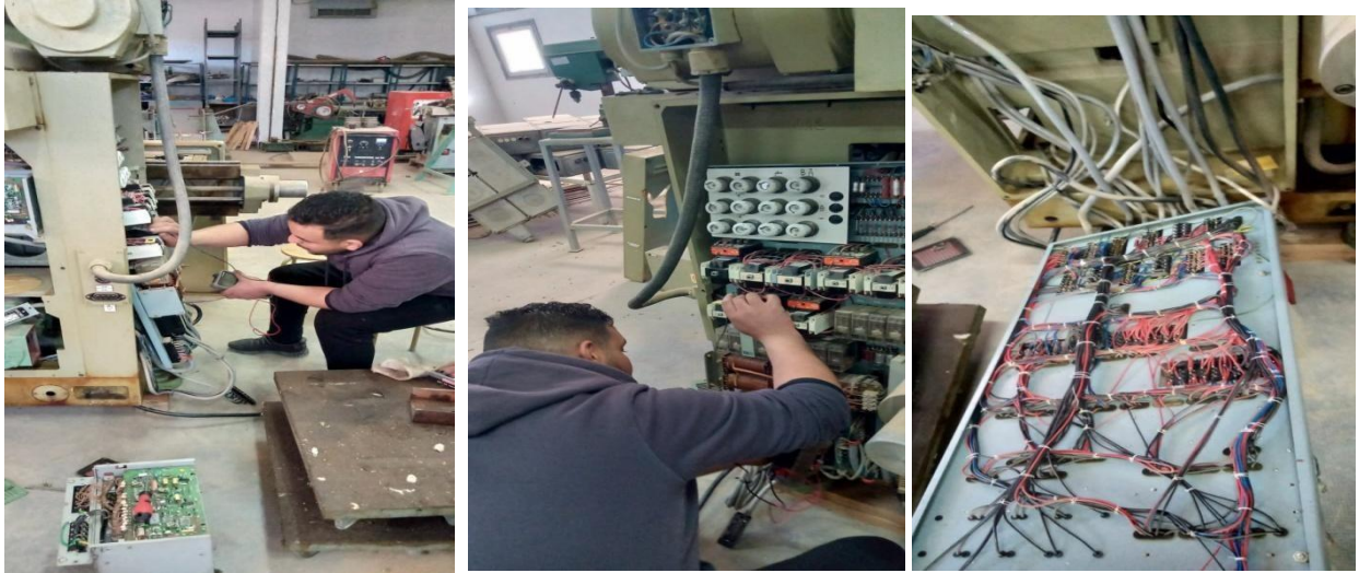
Figure IV.6. Vérification des Armoires électriques
