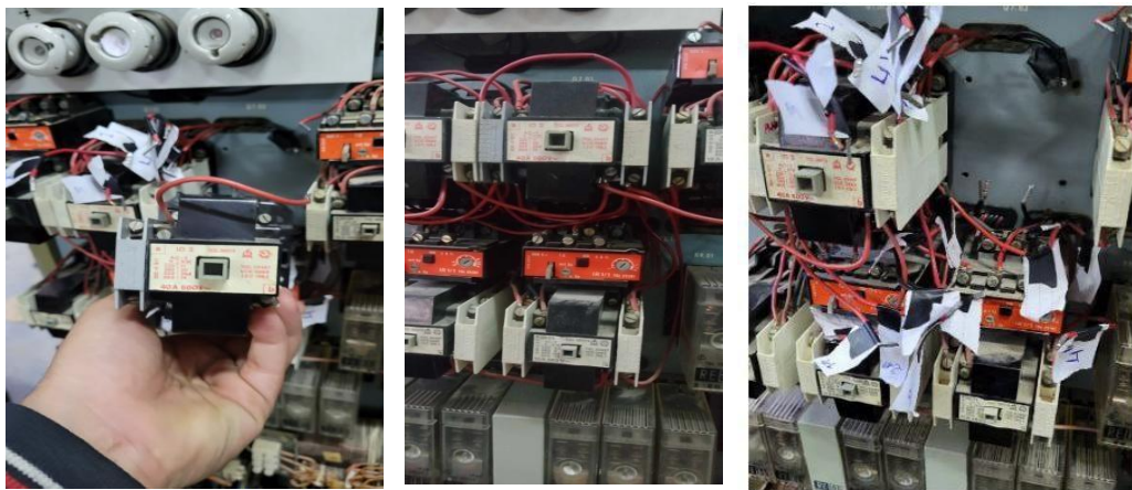
Figure IV.7. Le contacteur avec auxiliaire de commande
