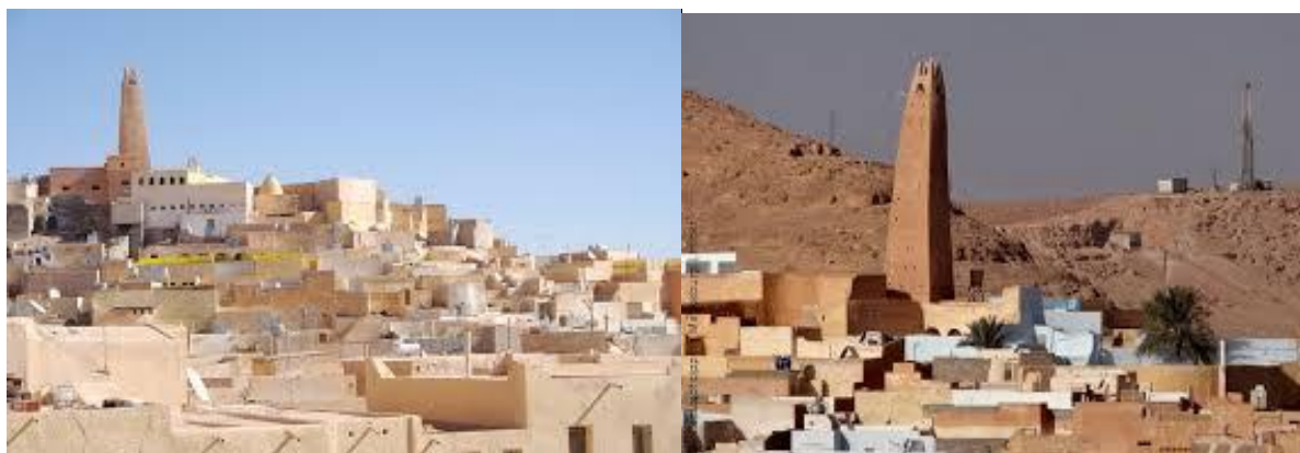
Fig.I.6 Constructions en blocs de terre comprimée Stabilisée avec la Chaux (ville de Ghardaïa)
