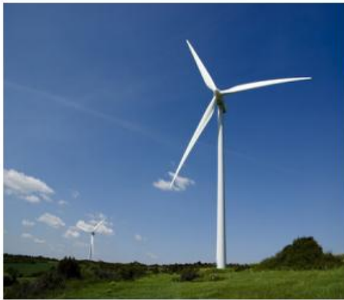
Eolienne à axe horizontal
