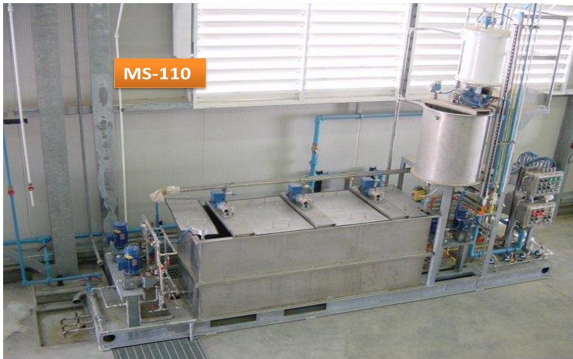
Figure (I-12): Station de préparation et dosage de la silice activée "SILIDOX"
