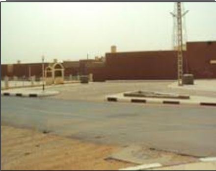
الصورة رقم (27): خط كهربائي
