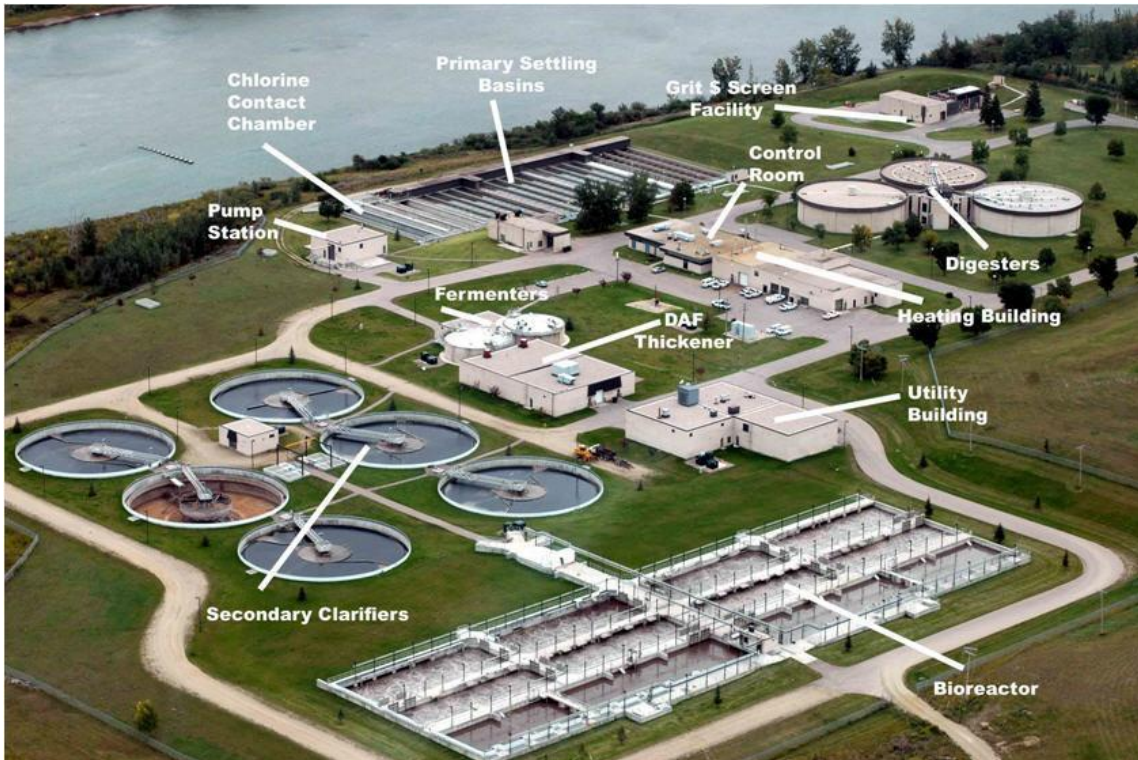
صورة رقم 5: مكونات محطة التصفية
