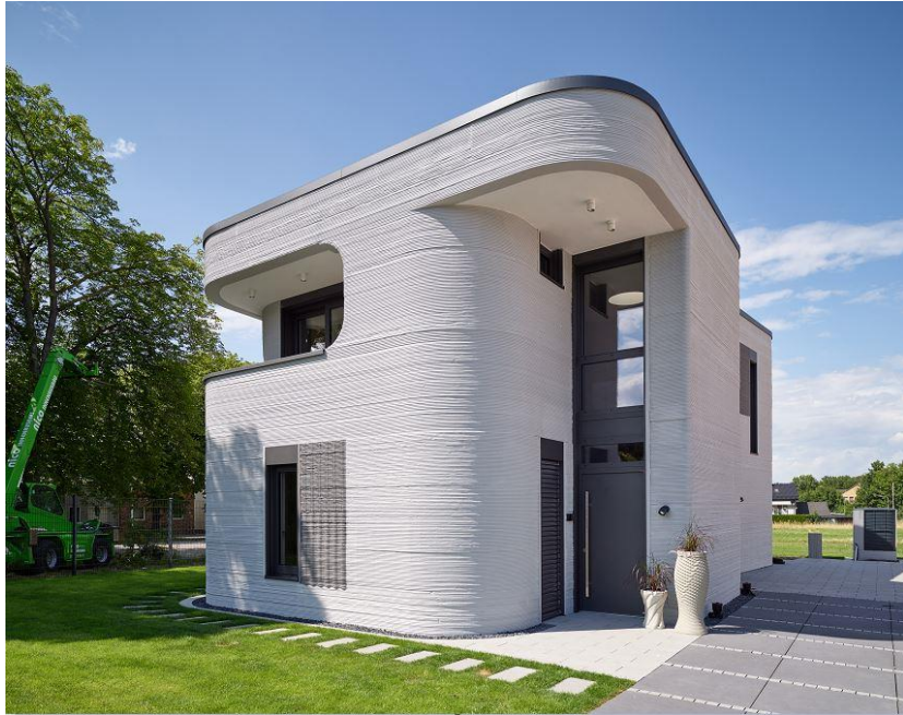
Figure II.25 : Une maison totalement imprimée en 3D [14].
