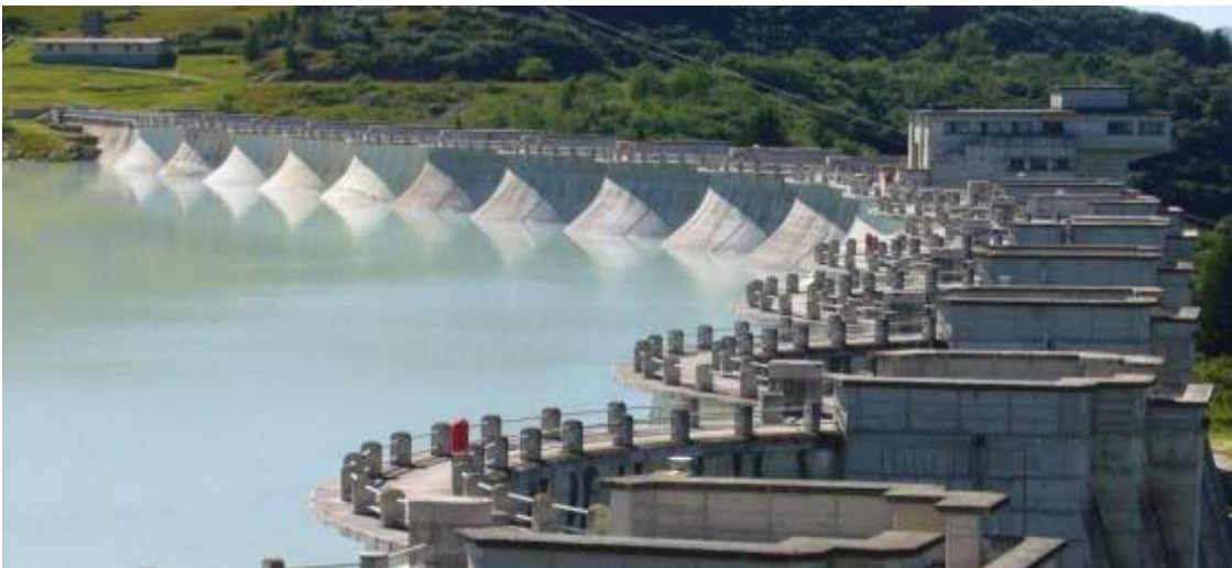
Figure 1.9 barrage de la Girotte- multi-voûtes
