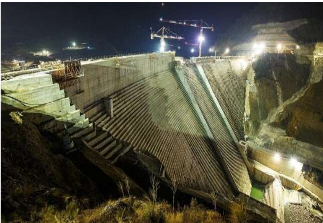
Figure I.11 : barrage de Tabellout Jijel- Algérie
