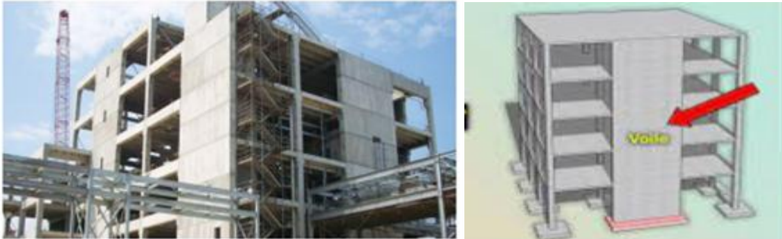
Figure II.5 : Structure portique en béton armée [3]
