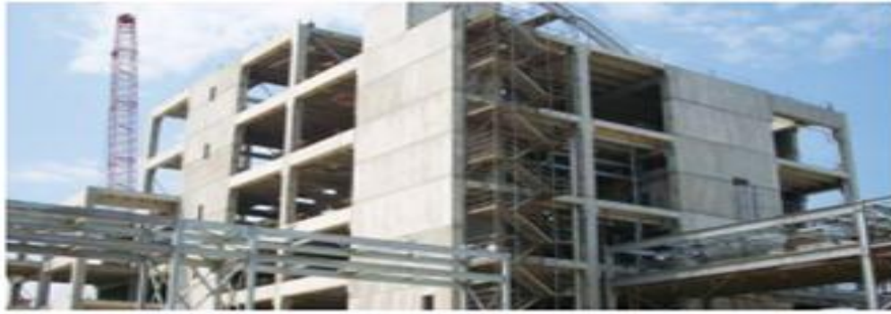
Figure II.8 : portique auto stable en béton armé avec voile.
