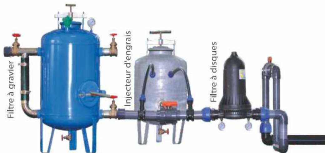
Figure 19 Installation de tête ( http://www.groupe-chiali.com )
