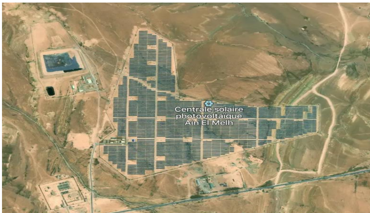
Figure I. 11 Parc énergétique de Ain El Melh, d'une puissance de 40 MW C , situé en Ain El Melh, en Algérie.
