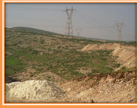
الصورة 36: خط كهربائي
