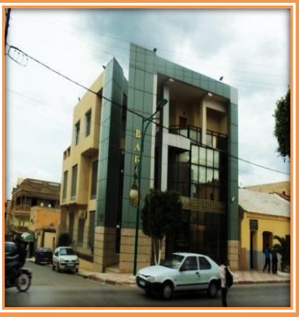
الصورة 15: تجهيزات ادارية
