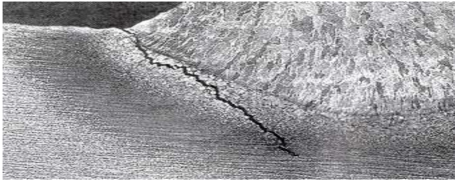
Fig. II.1.- Fissure dans une Soudure en T :
