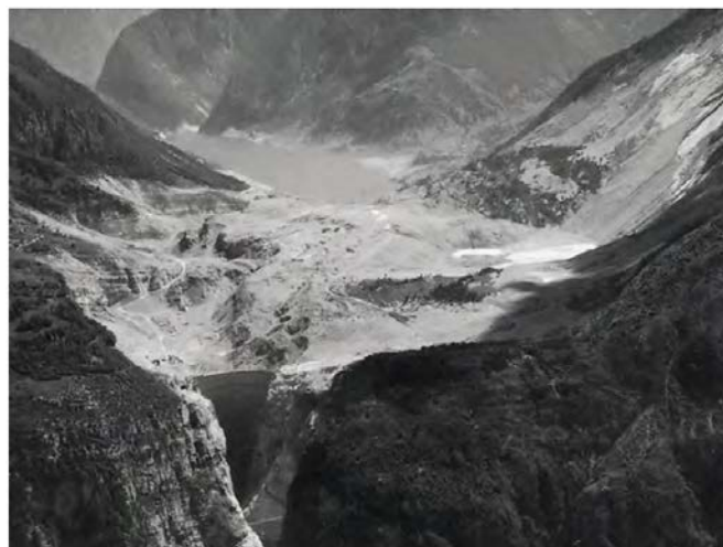
Fig I.19 Barrage du Vajont après le mouvement de terrain (Italie 1959) [14]
