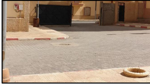
الصورة رقم (15): طريق ثالثي
