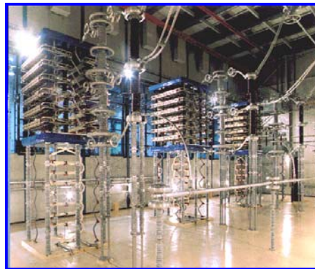
Fig. 1.12 : valve de thyristor
