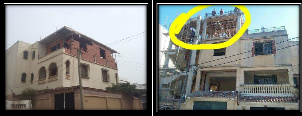
المصدر: معالجة ميدانية
