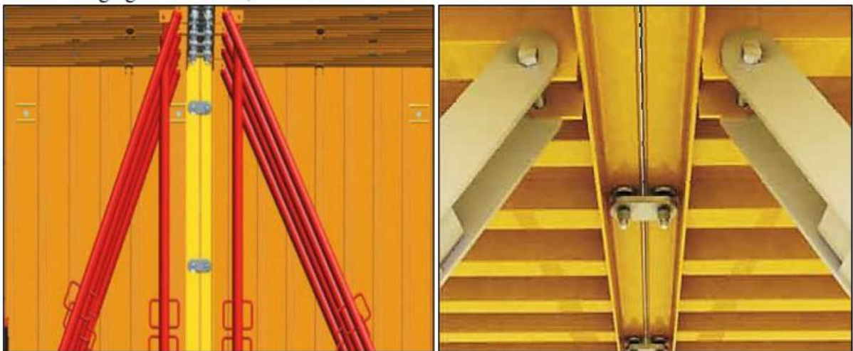
Figure I.13 : 5ème étape – Solidarisation des demi-coquilles [10]
