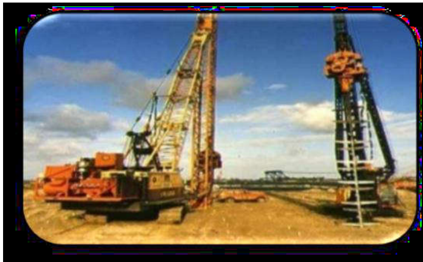
Fig. I. 7 Compactage par vitro-sonde.
