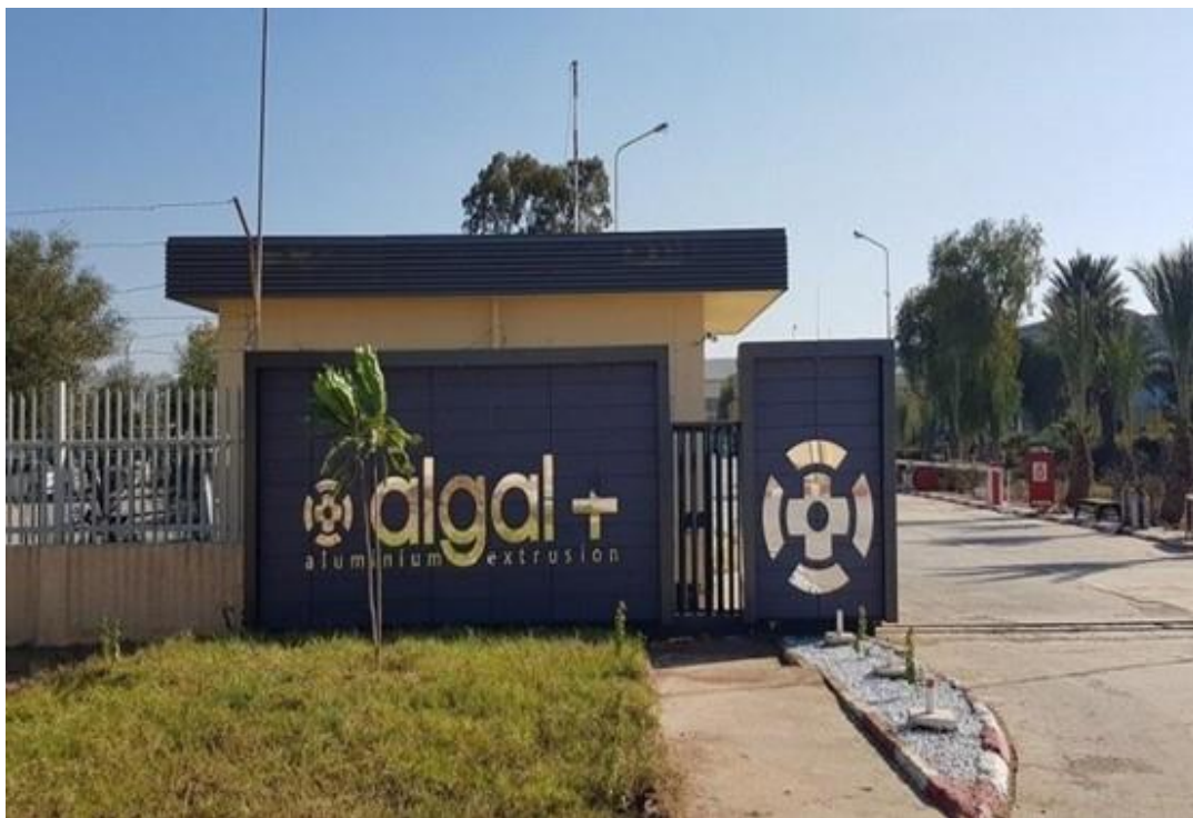
Figure 1 : Entrée du complexe ALGAL + - M'sila
