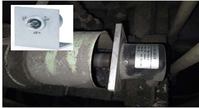
Figure 3.3 : Mise en place de l'encodeur rotatif en accouplement avec le moteur hydraulique.
