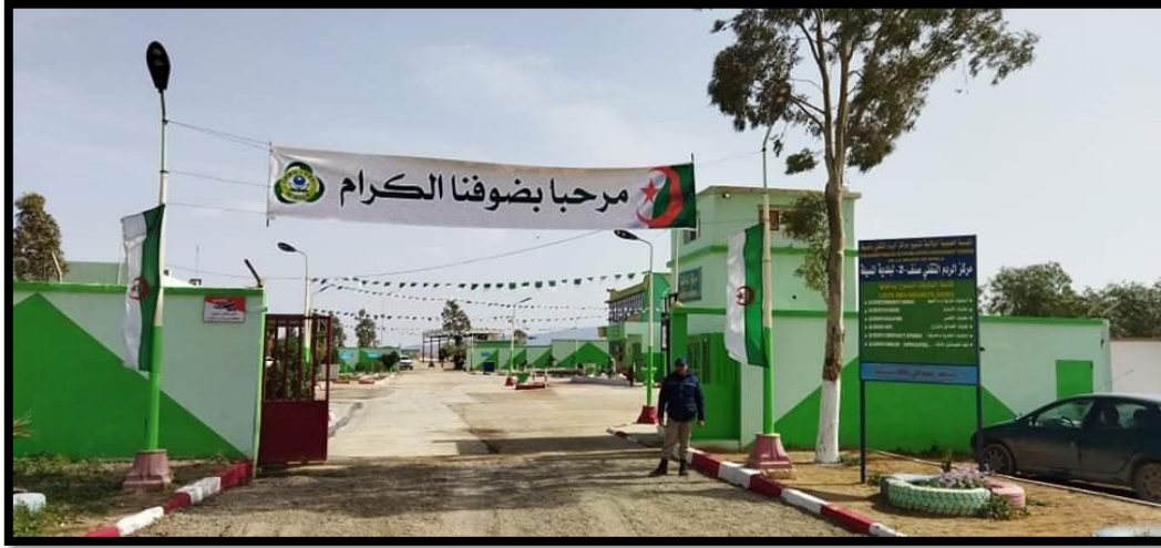
الصورة رقم 20: مدخل مركز الردم التقني بالمسيلة.
