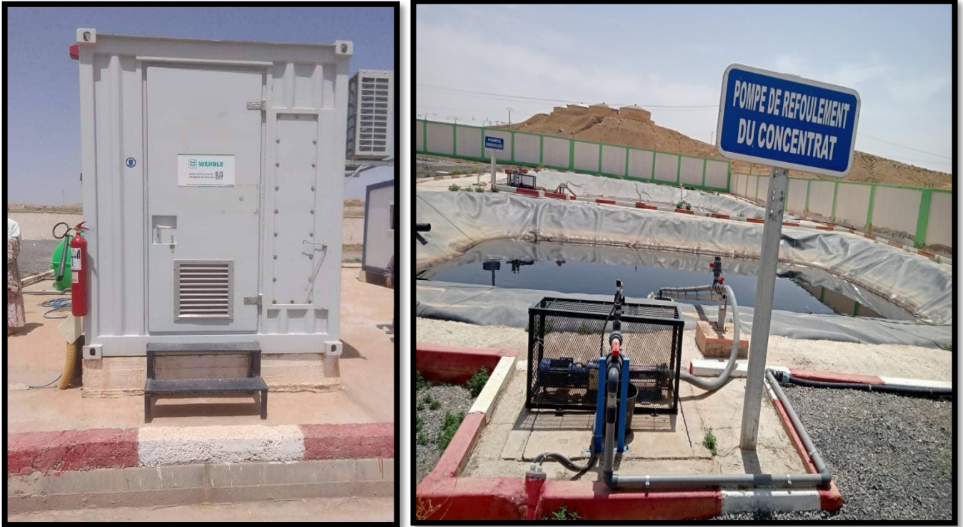
الصورة رقم 32: أحواض ترسيب العصارة و محطة معالجة العصارة.(التقاط الطلبة)
