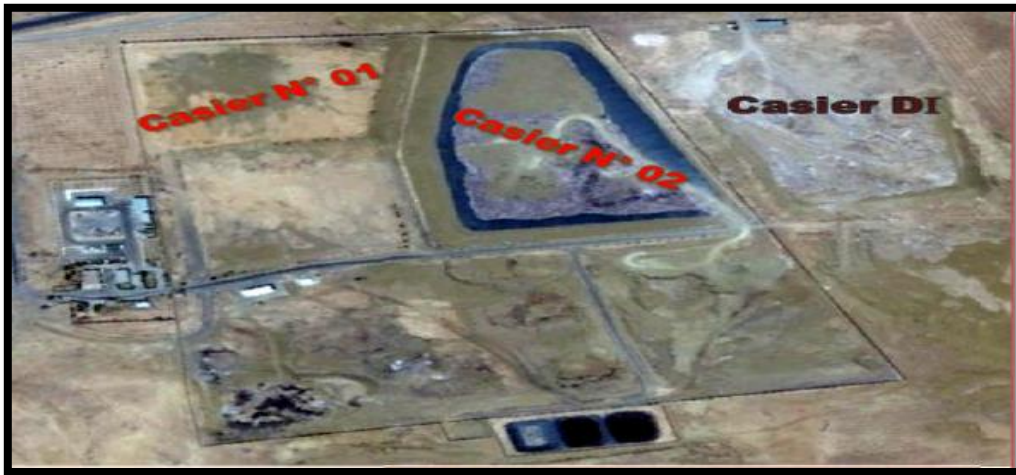
الصورة رقم 22: الخنادق الموجودة في مركز الردم التقني بالمسييلة
