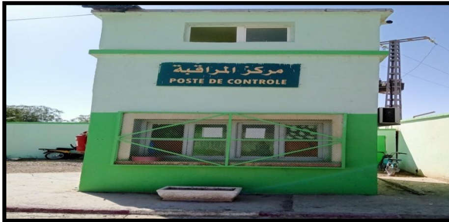
الصورة رقم 29: مركز المراقبة لمركز الردم التقني بالمسييلة.
