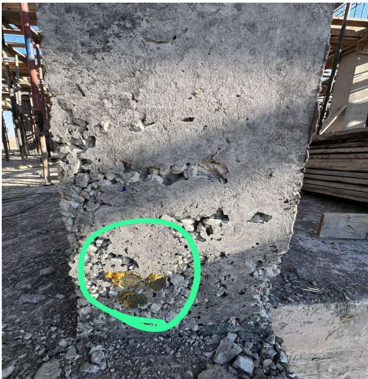
الملحق 02 صورة تمثل أثر الاختبار الذي أجرته CTC على احدى الاعمدة في حالة التعشيش
