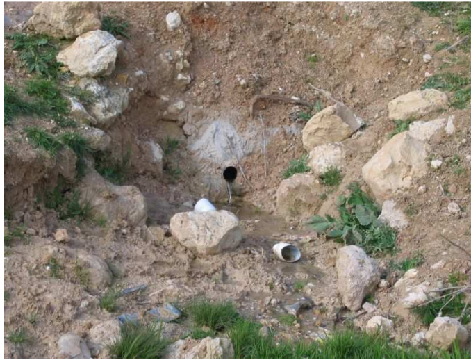
Figure III.6 : Source captée à la base des colluvions grossières, au contact avec les argiles miocènes à Boussouf [36].
