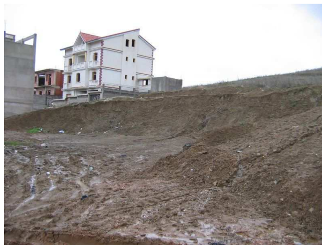
Figure III.7 : Argiles miocènes, décomprimées en surface, instables [36].
