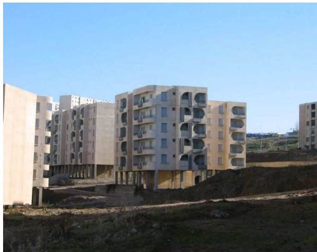
Immeuble incliné de la cité CNEP
