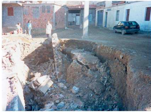
a. Glissement Smina: Vue sur l'escarpement et sur les 3 dalles d'une habitation
