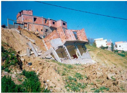
b. Glissement de Tizi : basculement d'une habitation
