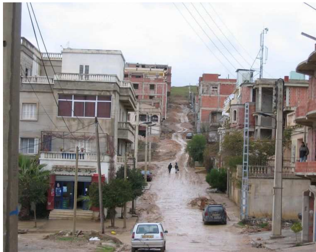
c. Constructions gagnant sur un versant de pente de stabilité critique sans drainage suffisant
