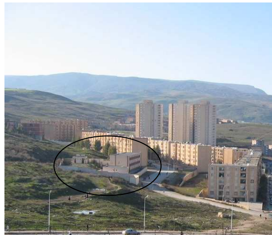
Ecole menacée par un glissement à l'amont.
