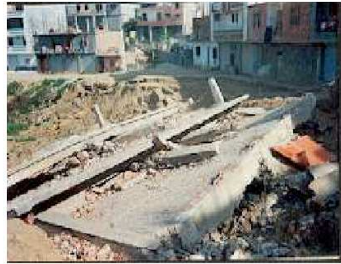
a. Glissement Smina: Vue sur l'escarpement et sur les 3 dalles d'une habitation
