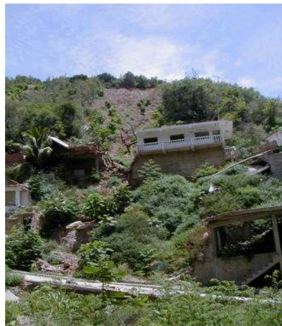
d. Déplacement des constructions, Quebrada Vargas, Venezuela 1999, [http://pubs.usgs.gov/].
