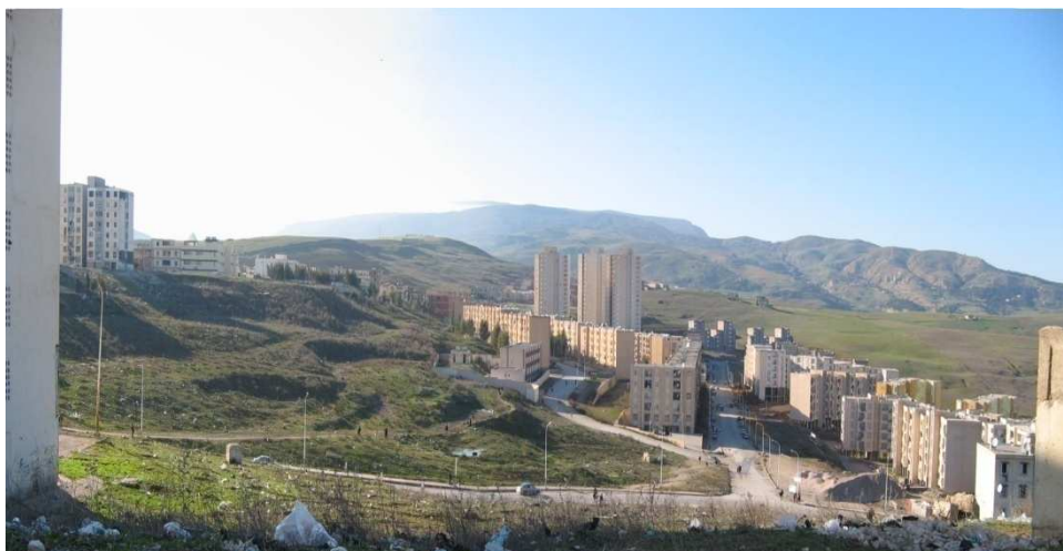
Figure III.9 : Vue d'ensemble du site de Boussouf - Thalweg Ouest [36b]
