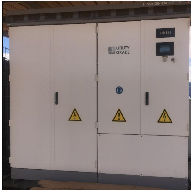
Figure III.5: Armoire de l'onduleur de type Sunny Central 880CP XT.
