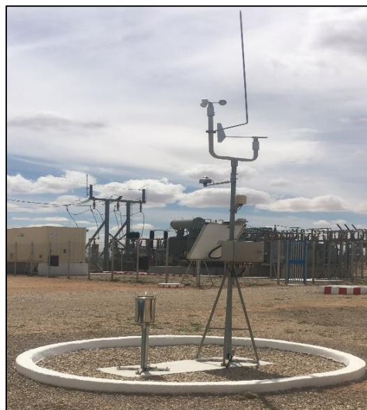
Figure III.8: Mini station météorologique de la centrale d'Aïn Skhouna [54].
