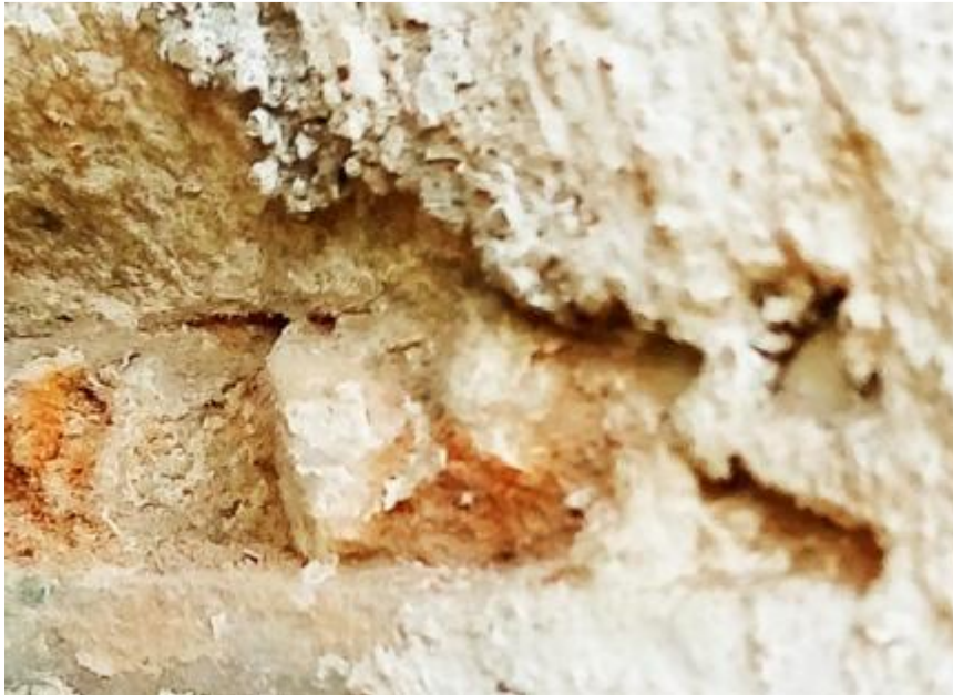
الصورة رقم 10 2 : جزء من الجدار مكشوفتظهر من خلاله مواد البناء (الآجر، قطع الحجارة)
