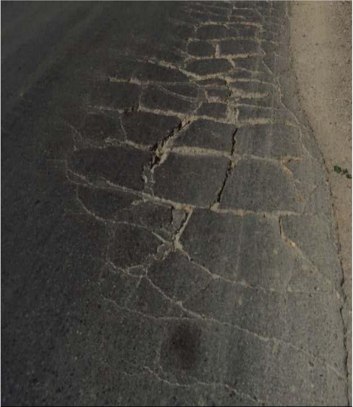
Figure AI.4 photographie de faïençage à mailles larges
