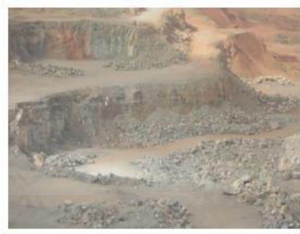
Figure I. 2.carrière d'extraction d'argile et de calcaire de hammam bouziane .
