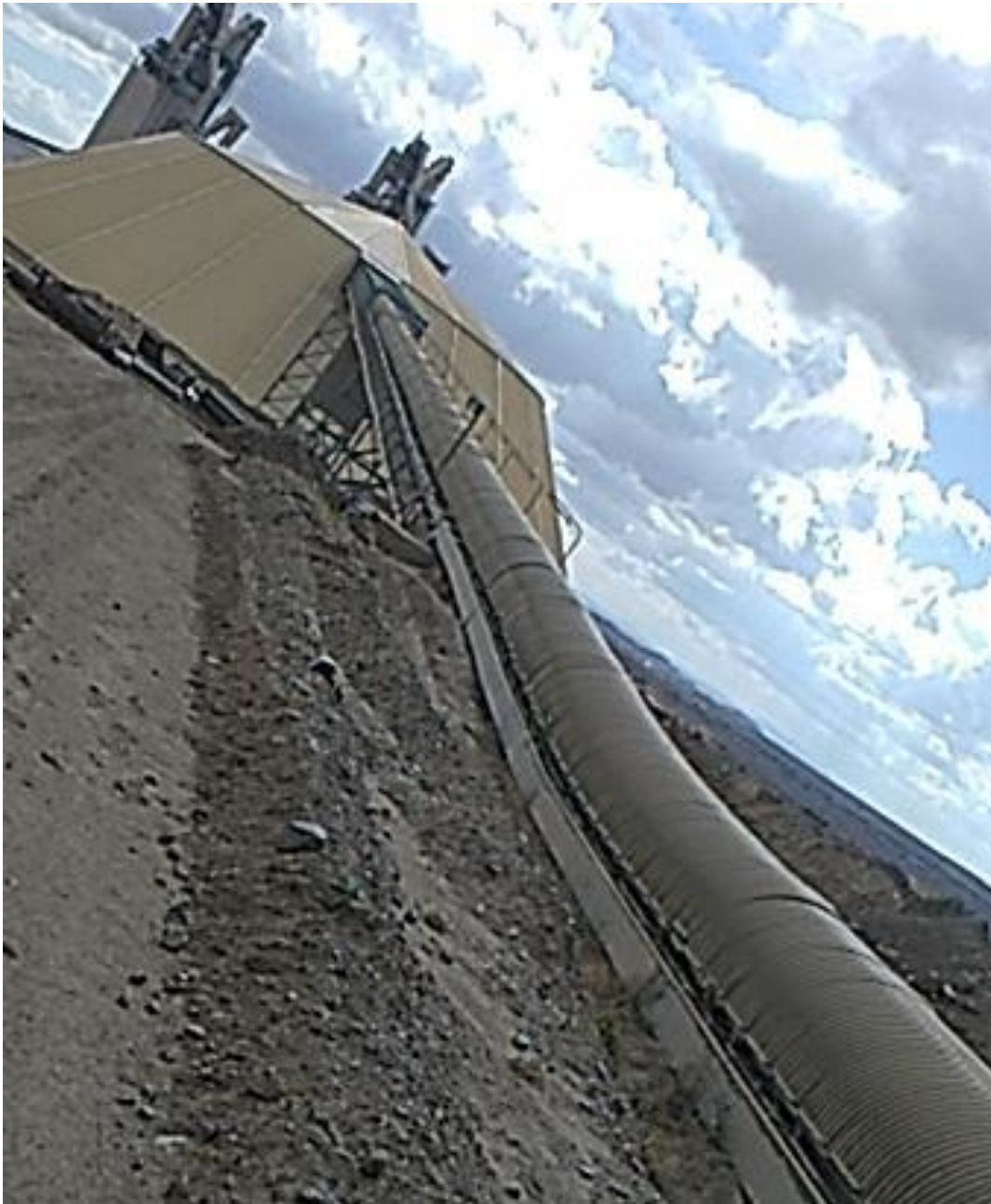
Figure I. 4. Hall de pré homogénéisation (Hammam d'alaa).
